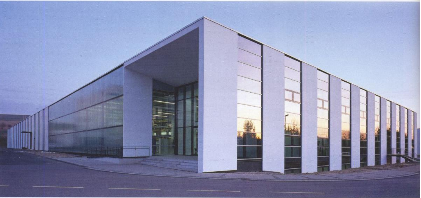
Betonfertigteilelemente stehen im Wechsel mit verglasten Pfosten-Riegel-Konstruktionen im Bürotrakt und Gussglasfassaden im Hallenbereich
